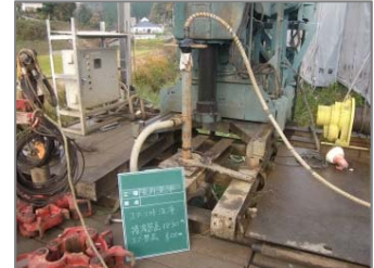
エアリフト浚渫状況
