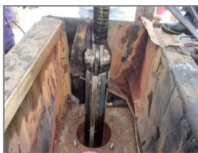
揚湯管・ポンプの引上げ
