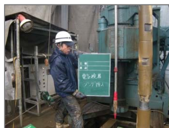
温度・電気伝導度検層実施状況
