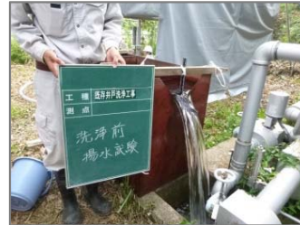
揚湯試験実施状況
