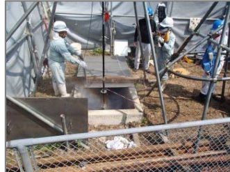
ジェットング洗浄状況
