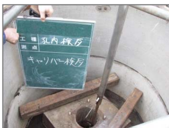
坑径検層実施状況
