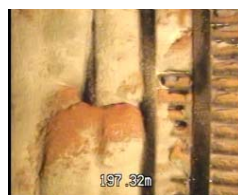
スクリーンが目詰まりし、温泉湧出を阻害
