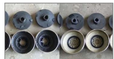
ポンプ分解・点検・洗浄写真 (左: 洗浄前、右: 洗浄後)
